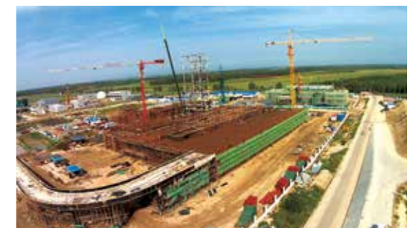
垃圾焚烧项目
