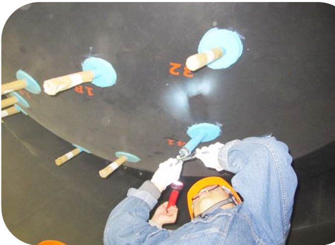
福清 3_ 反应堆压力容器 neutron 通量管开箱联合检查测量
