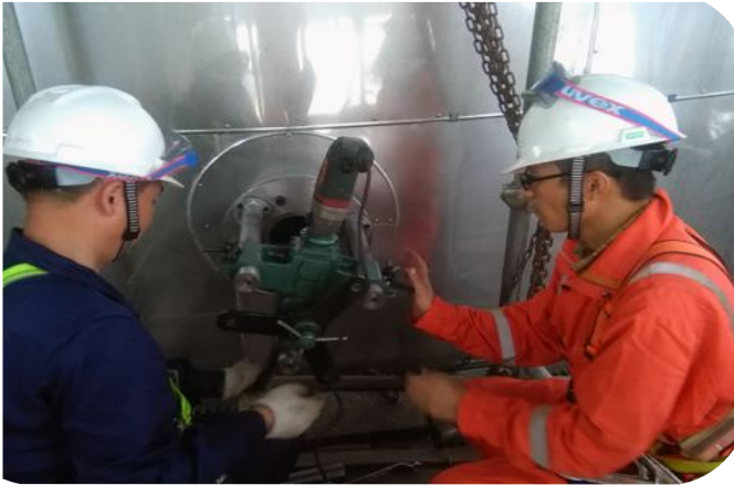
广东珠海 BP 石化现场开展结晶器接管内壁加工工作
