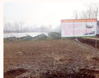
光伏发电项目
